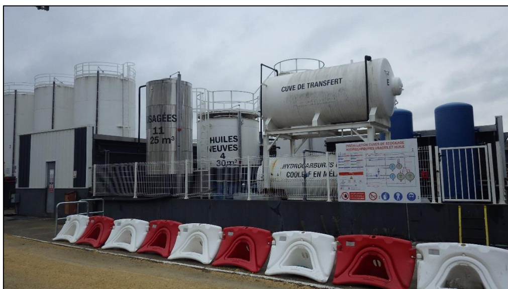
Figure 70. "Huilerie" - Cuves de stockage des huiles neuves et usagées et des hydrocarbures et liquides de refroidissement en mélange (Cliché : Antea Group, 2016)
