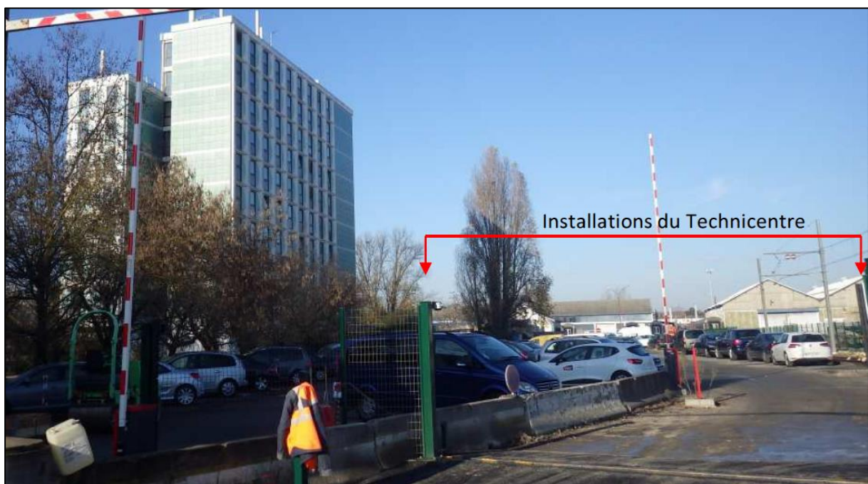
Figure 49. Habitat collectif (R+9) en limite du Technicentre (secteur Bombe) (crédit : AnteaGroup)
