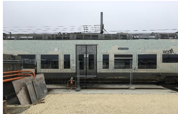
Photographie du chantier : remise en état
