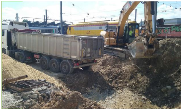
Photographie du chantier : excavation et chargement des camions pour évacuation en filière adaptée
