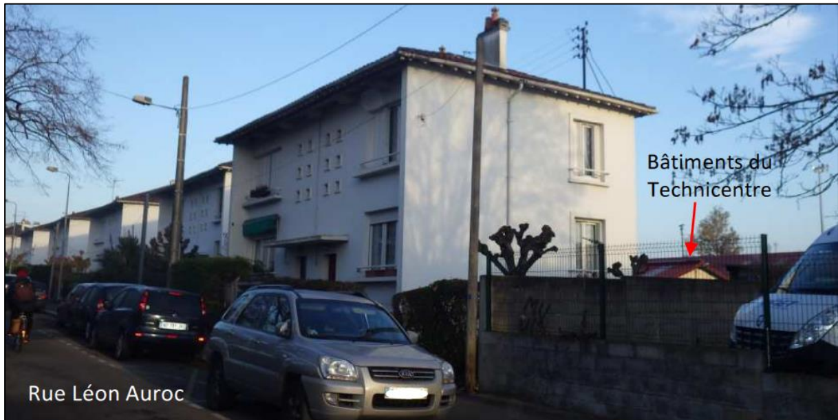
Figure 48. Exemple d'habitations en R+1 rue Léon Auroc, en limite du Technicentre (crédit : AnteaGroup)
