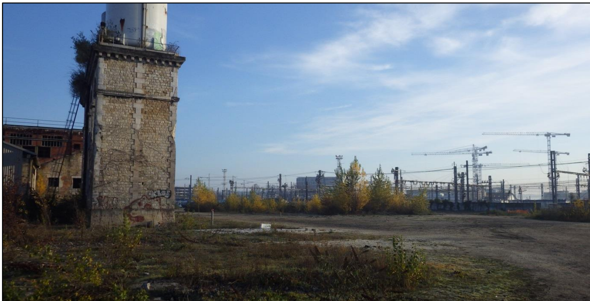
Figure 53. Terrains en mutation de la plateforme ferroviaire à l'Ouest du Technicentre (terrain vague, bâtiment désaffecté) (crédit : AnteaGroup)
