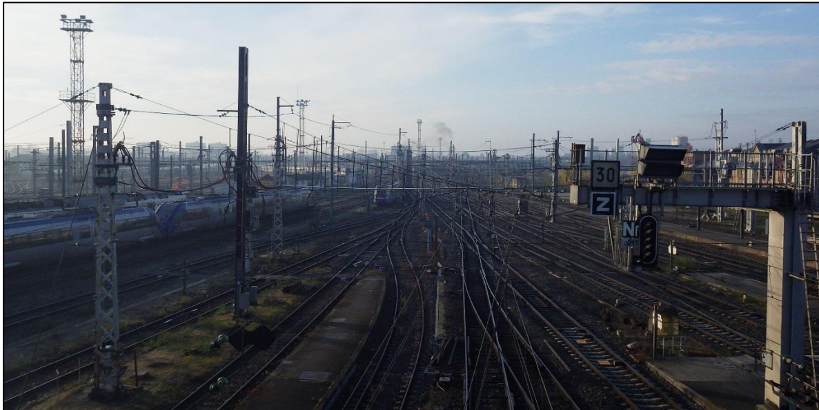
Figure 31. Vue en direction du Technicentre depuis le pont du Guit (crédit : Antea Group)
