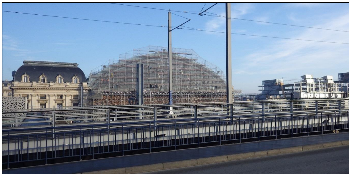
Figure 30. Gare St Jean (en travaux) vue depuis le pont du Guit (crédit : Antea Group)
