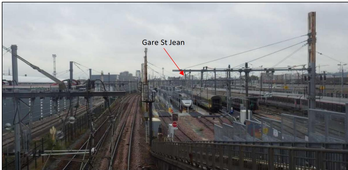
Figure 29. Vue vers le Nord depuis l'intérieur du Technicentre (crédit : Antea Group)
